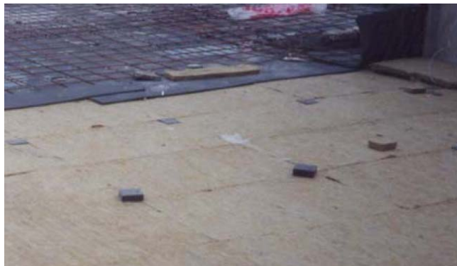
Figura R_INST-02. Ejemplo de un suelo flotante
