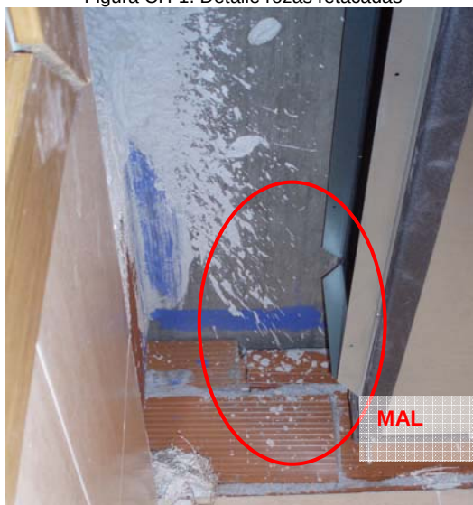
Figura CH-2. Detalle encuentro forjado partición
