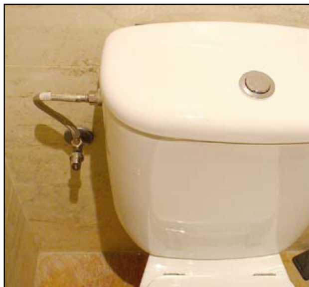
Figura CH-5. Conectores flexibles y junta elástica desolidarizadora
