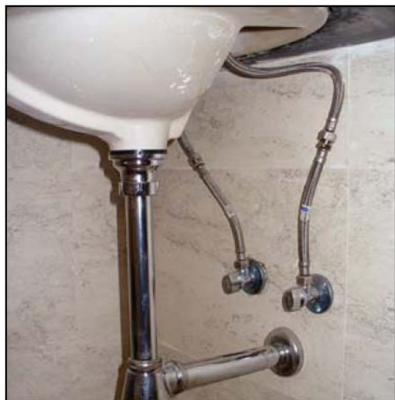
Figura CH-4. Conectores flexibles
