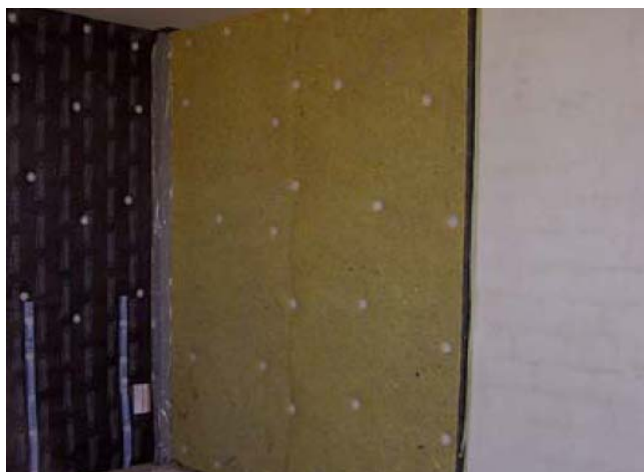
Figura R_INST-05. Ejemplo de un trasdosado
