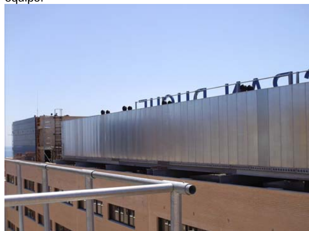
Figura 04. Detalle de la instalación de pantalla
