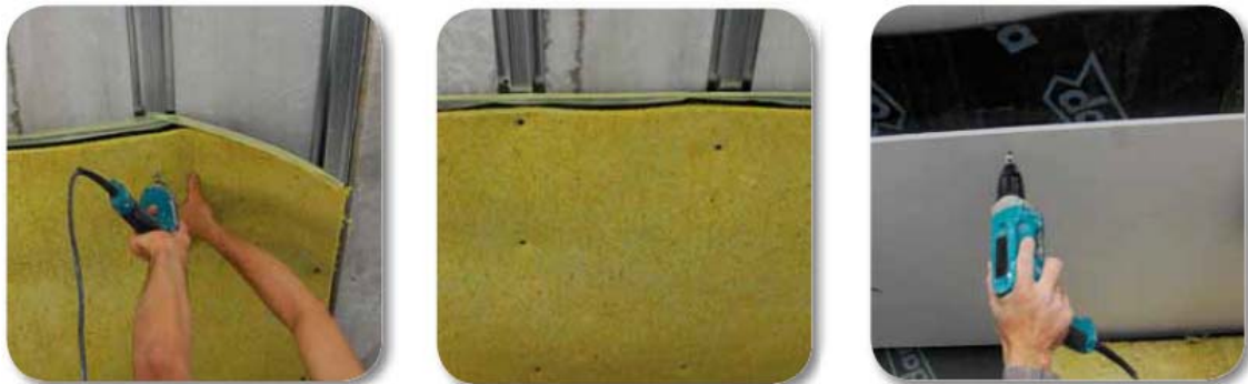
Foto 6. Colocación de material multicapa en perfilaría auxiliar. Detalle de membrana de alta densidad.
