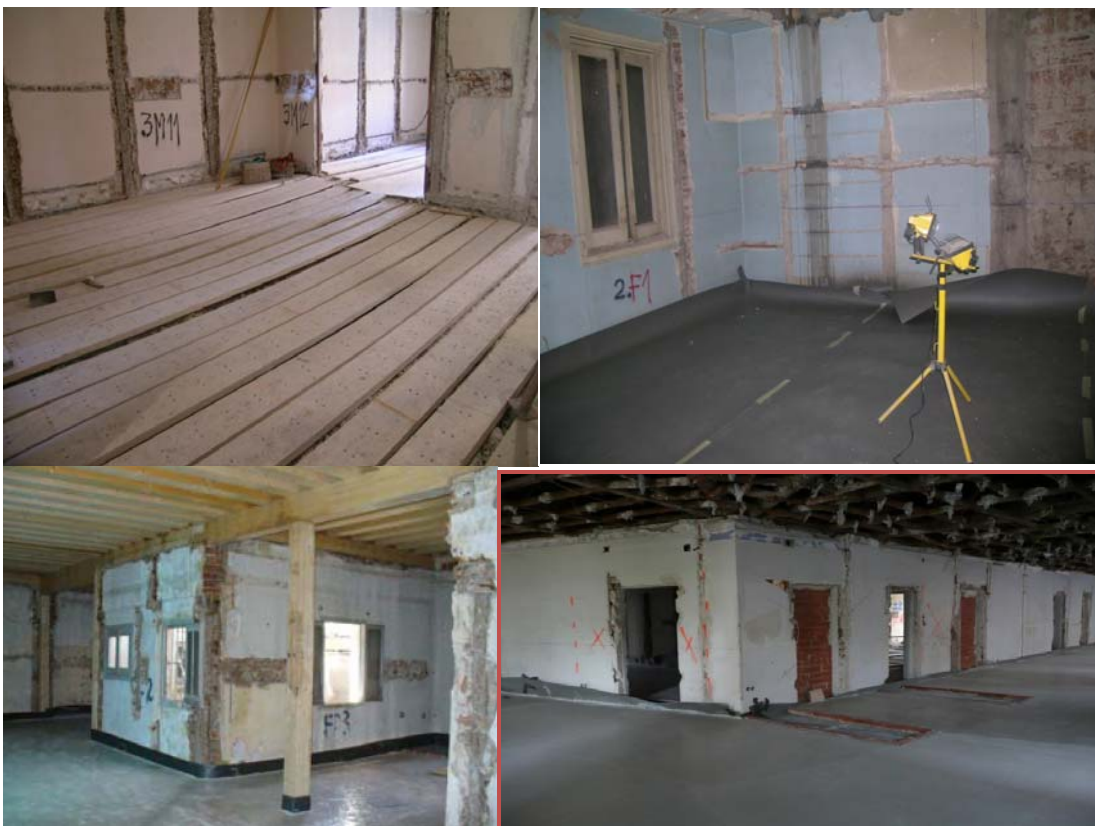
Figura 18. Ejecución de un suelo flotante de mortero sobre polietileno en una actuación de rehabilitación
