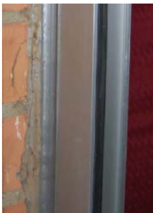
Figura 17. Sellado carpintería a fábrica.
