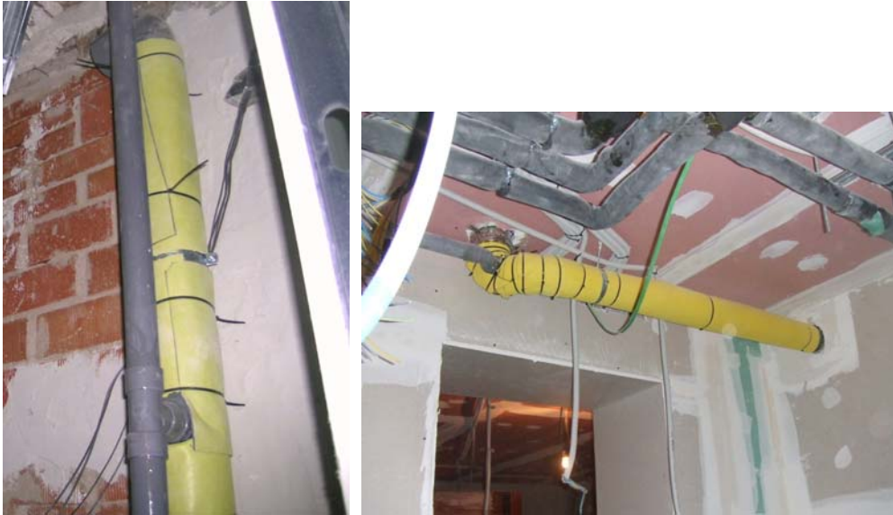
Figura 27. Forrado de bajantes en una actuación de rehabilitación
