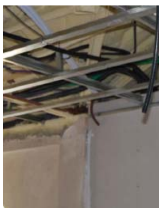
Figura 19. Cubierta ligera rehabilitada desde interior.
