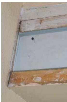
Figura 15. Aislamiento térmico capialzado
