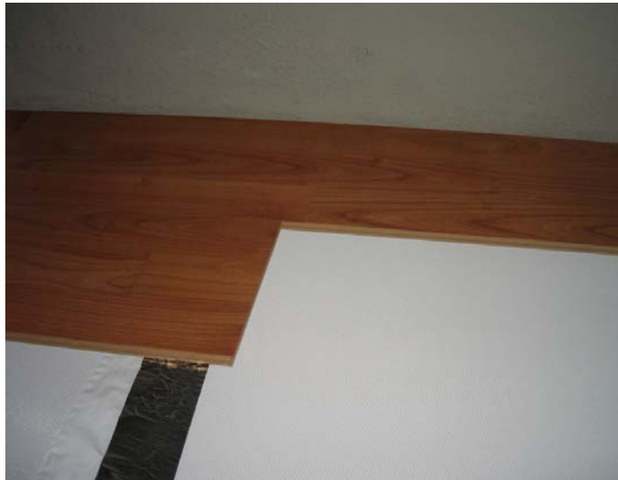
Figura 4. Detalle de instalación de la lámina de polietileno y la tarima/parquet.
