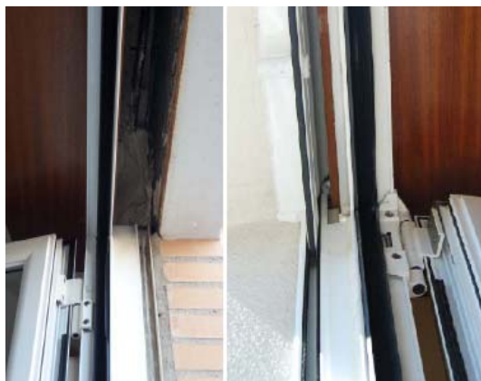
Figura 18. Corrección holgura entrada caja persiana con perfil aluminio.
