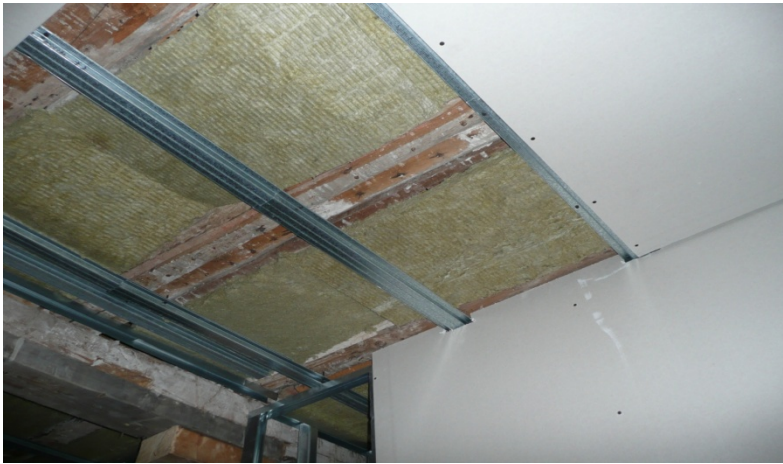
Figura 21. Ejecución de un techo suspendido en una actuación de rehabilitación
