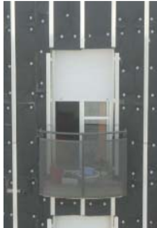
Figura 2. Aislamiento exterior Fachada ventilada
