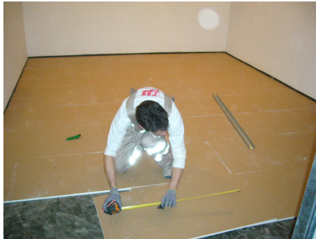
Figura 15. Instalación de solera seca de lana mineral y placa de yeso laminado
