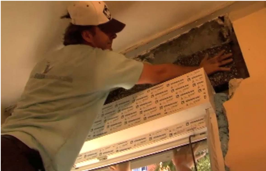
Figura 25. Sellado con masilla de alta densidad en cambio de ventanas
