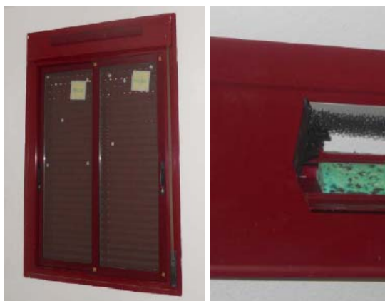
Figura 16. Aislamiento acústico en aireador.
