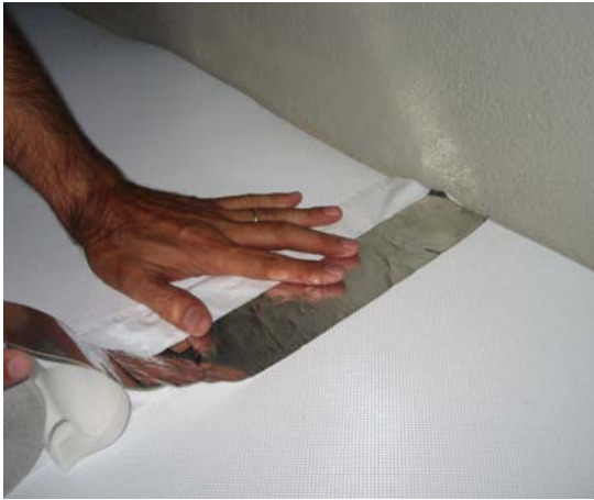
Foto 4. Colocación de tarima flotante. El sellado se realiza con cinta de aluminio para evitar la corriente estática.
