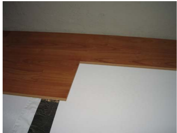
Foto 4. Colocación de tarima flotante. El sellado se realiza con cinta de aluminio para evitar la corriente estática.
