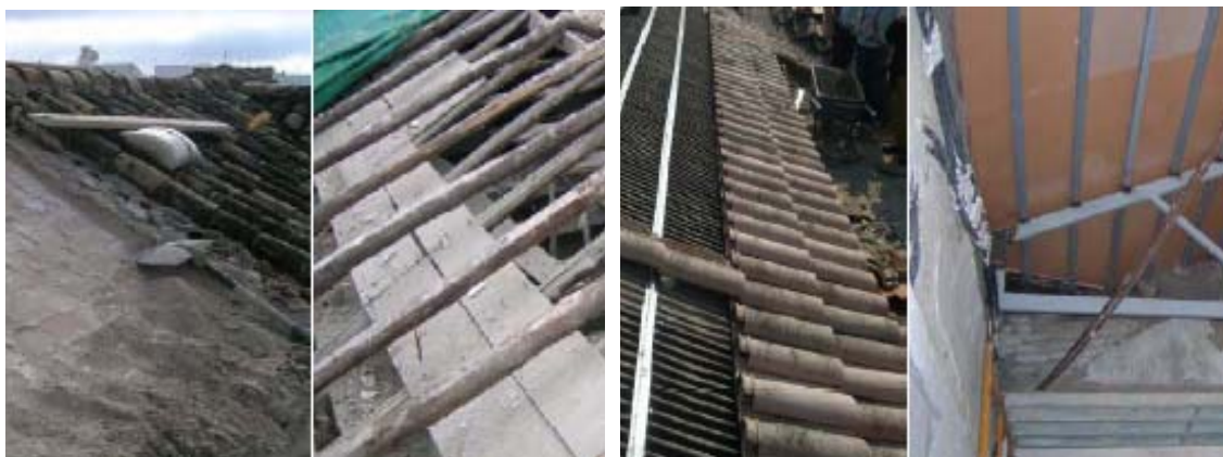
Figura 19. Cubierta ligera deteriorada con rehabilitación desde exterior.
