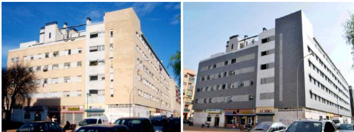
Figura 1. Aislamiento exterior. (SATE)
