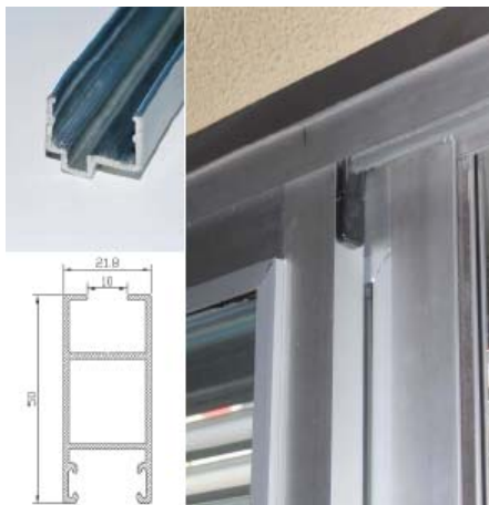
Figura 6. Acristalamiento con perfil adaptación.
