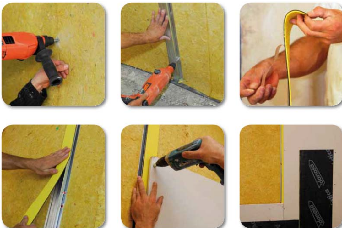
Foto 2. Solución multicapa 7 cm sobre ladrillo
