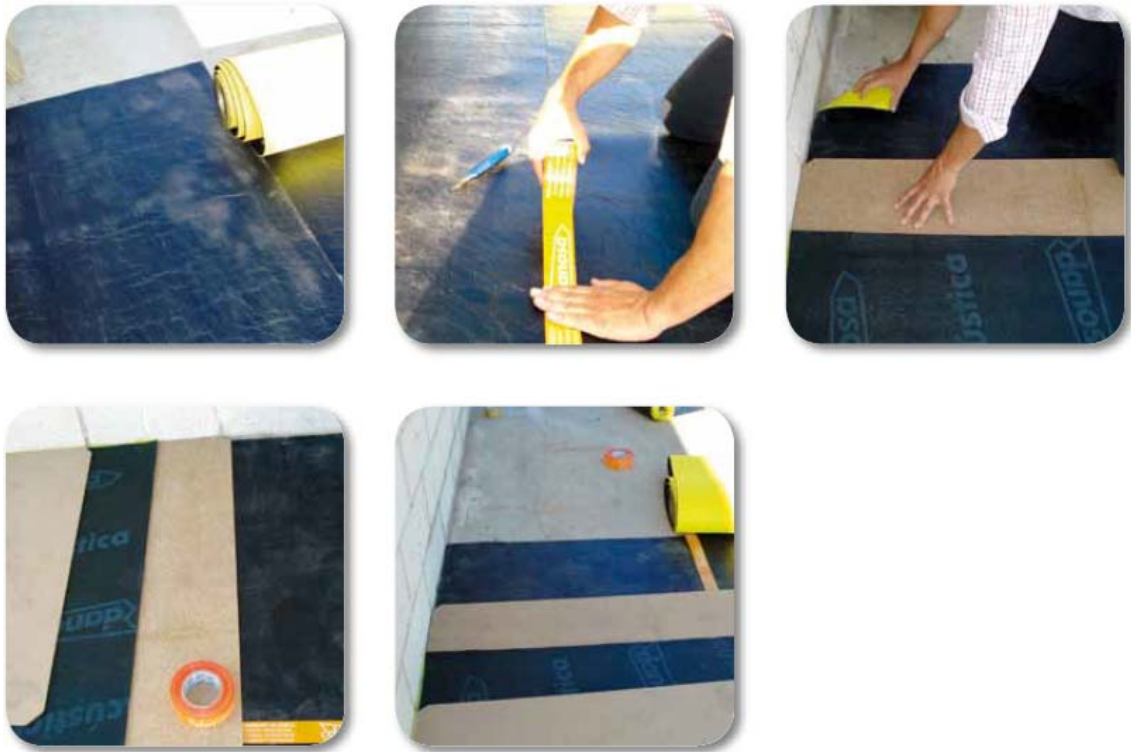
Foto 5. Colocación de suelo flotante "seco" sobre material elástico multicapa
