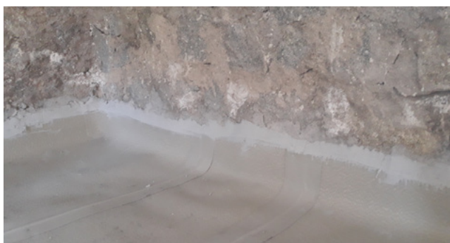
▼ Figura 12 - Sellado de la lámina en la junta perimetral
