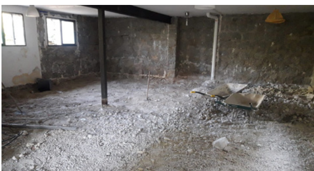
▼ Figura 5 - Demolición de la solera existente
