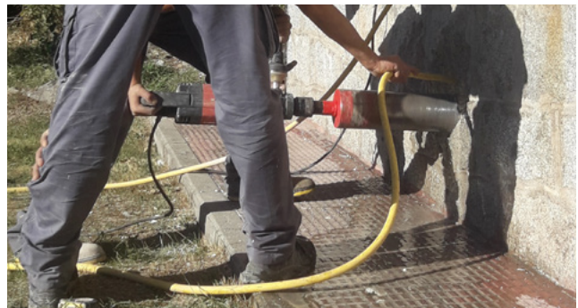
▼ Figura 7 - Perforación en la fachada para la salida del conducto de extracción
