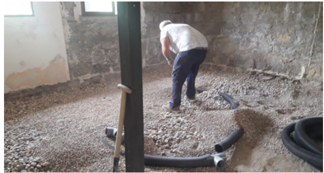
▼ Figura 6 - Instalación de los tubos perforados y de la capa de grava
